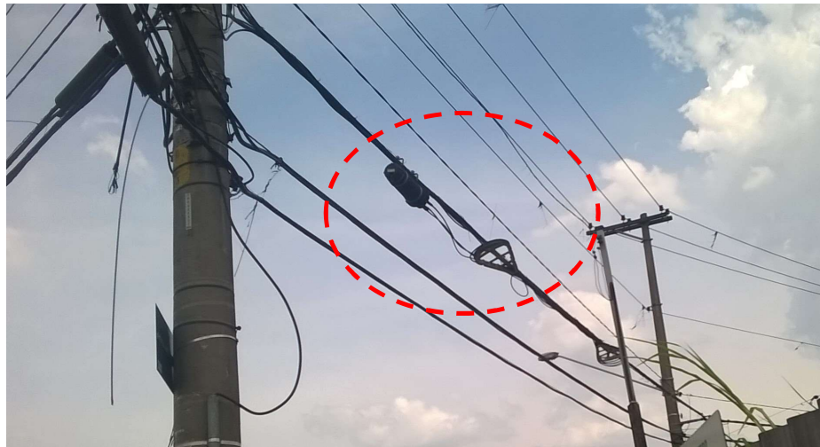
Emenda de fibra óptica
