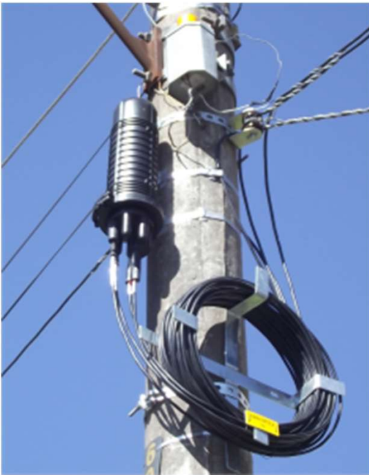
Emenda de fibra óptica
